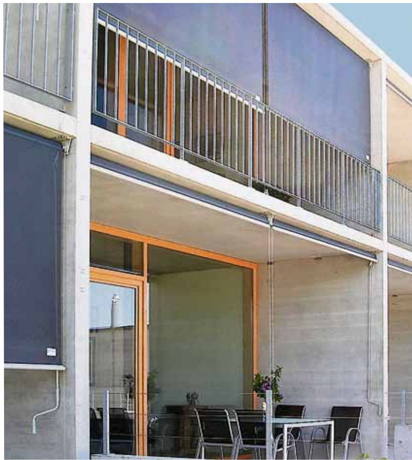
Balkone mit grauem Sicht- und Sonnenschutz, der mit einer Kurbel heruntergelassen und wieder hochgefahren werden kann.
